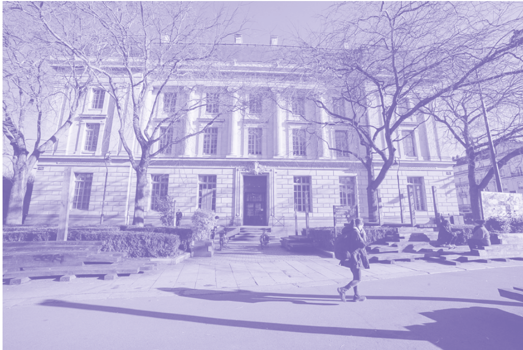
L'EXTÉRIEUR - VUE DE FACE
