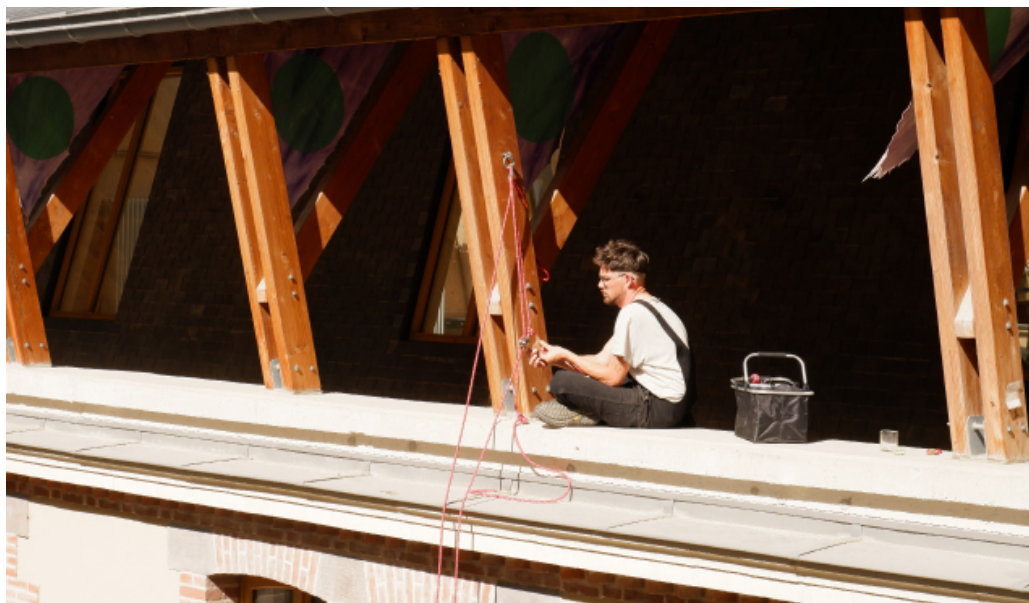
Clôture Hé Ho du Bateau, installation de la tyrolienne .
